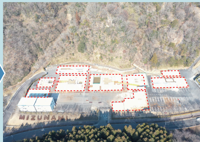
地上施設解体後（2022年2月）
