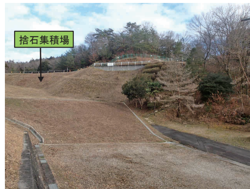
〈施設解体撤去後の状況〉
