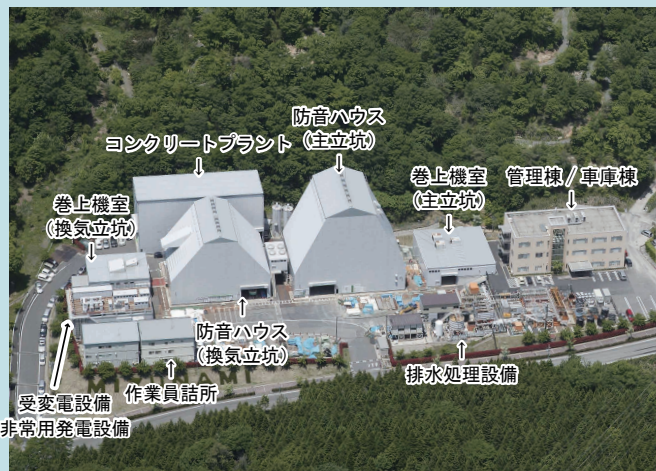
瑞浪超深地層研究所 地上施設解体前（2009年5月）
